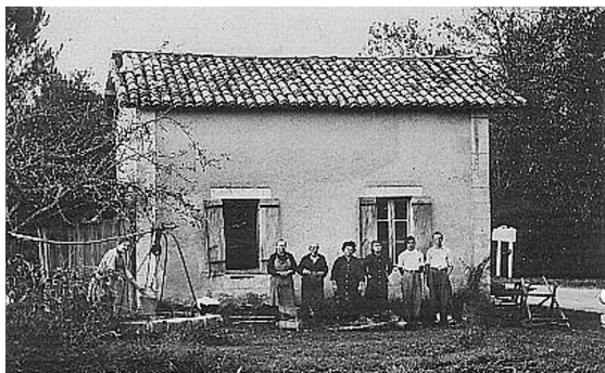
La maison cantonnière du Pont-Neuf était construite au croisement de la route de Montpon à La Roche-Chalais, là où arrivait la route du Pizou à La Roche-Chalais. Elle était destinée à un cantonnier chargé d'entretenir la nouvelle route. (photo collection particulière)
